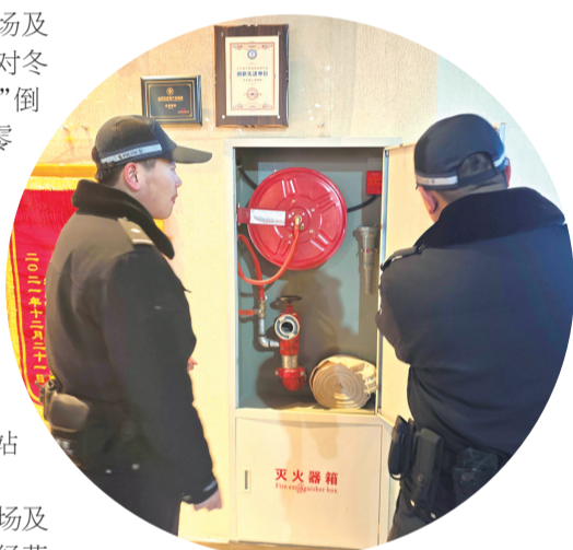
检查消防安全设施
