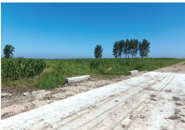
整改后，涵洞笔直顺畅衔接水渠，农田恢复种植。
