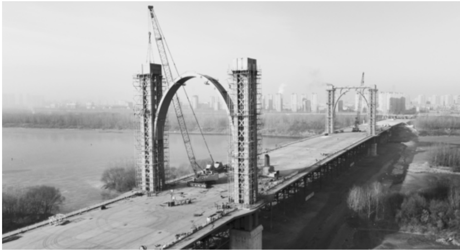
沈阳东塔桥双主塔安装完成
