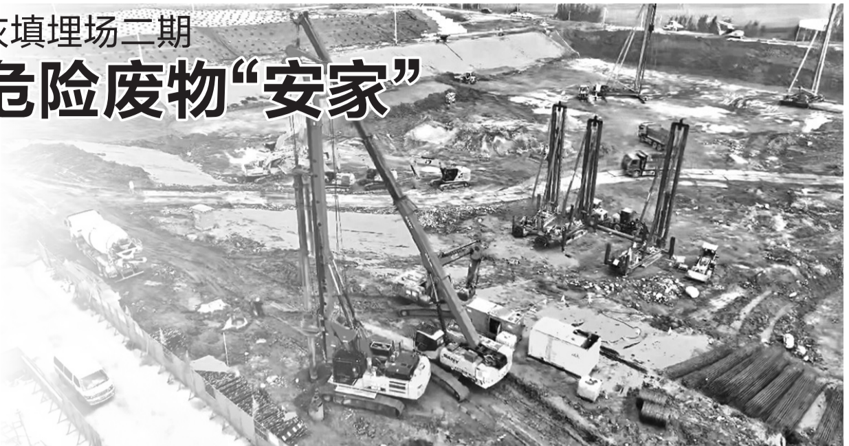
沈阳市城管执法局正在推进的大辛、老虎冲飞灰填埋场二期工程现场。
