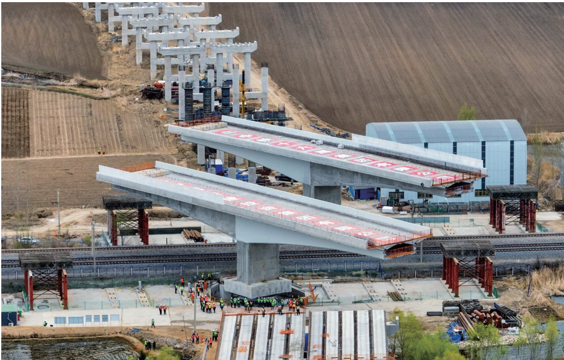
4月14日,凌绥高速公路全线唯一一座双幅曲线转体桥实现成功转体。
