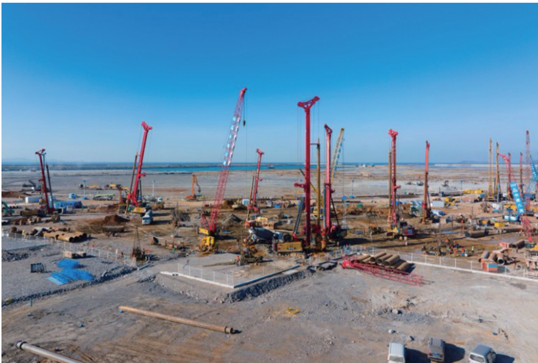
大连金州湾国际机场建设全面提速,2月高峰时段预计投入车辆设备1000余台。
