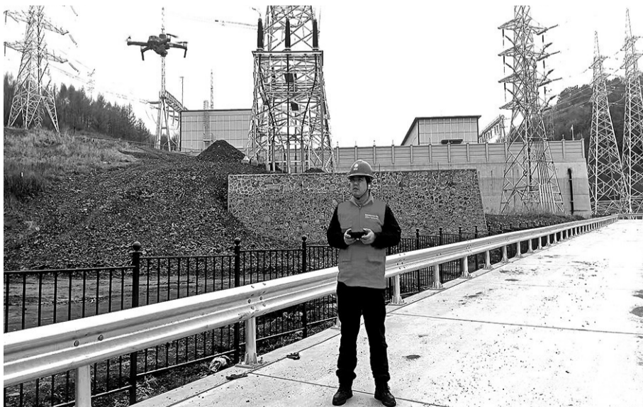
国网抚顺供电公司工作人员利用无人机对“城市生命线”进行特巡。
