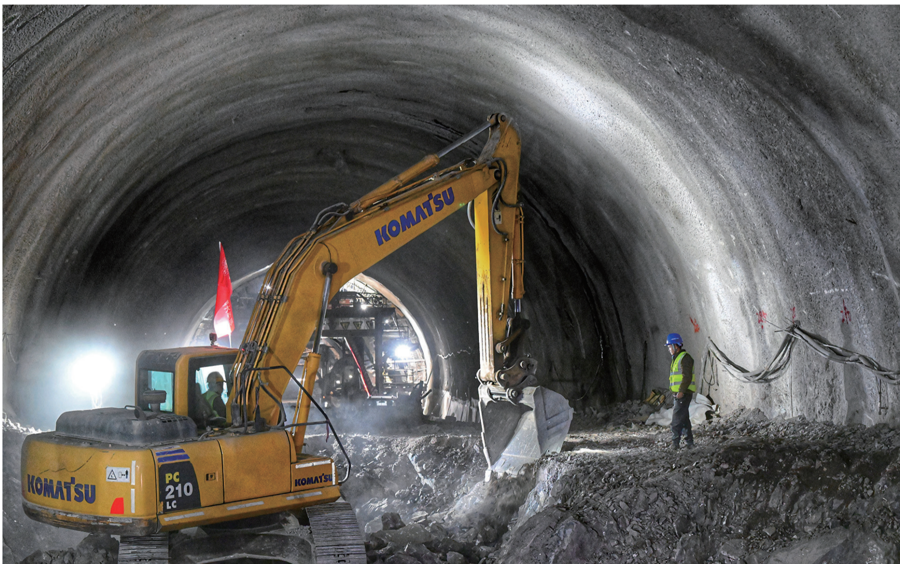
日前,凌绥高速公路白狼山2号隧道顺利贯通。
