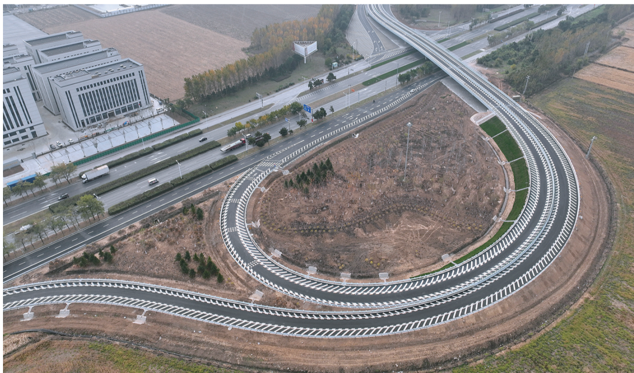
苏家屯南立交工程 提前三月竣工通车
