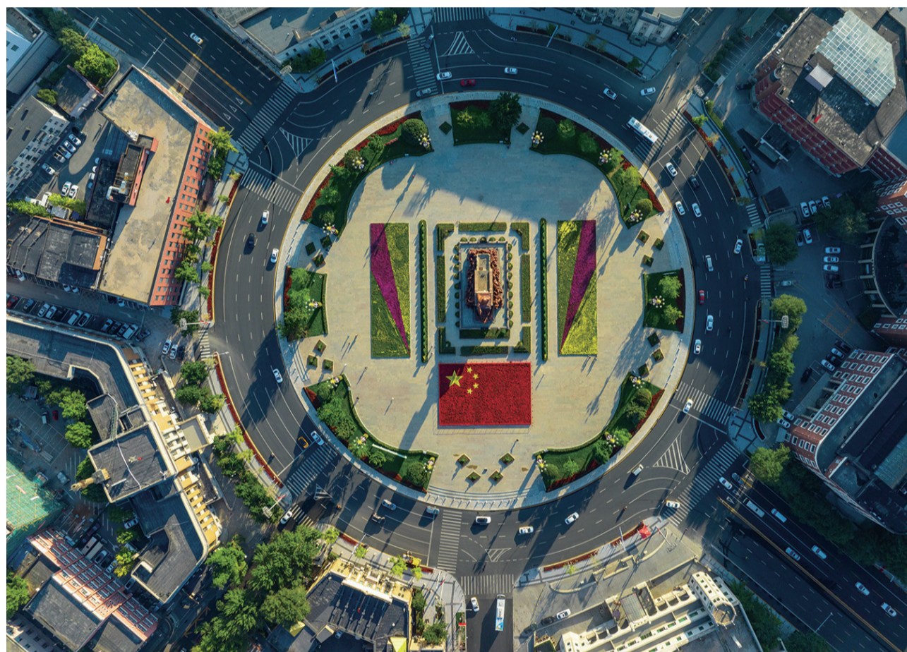
百年老街南京街-黄河大街更新全面完工,这是改造后的中山广场。
