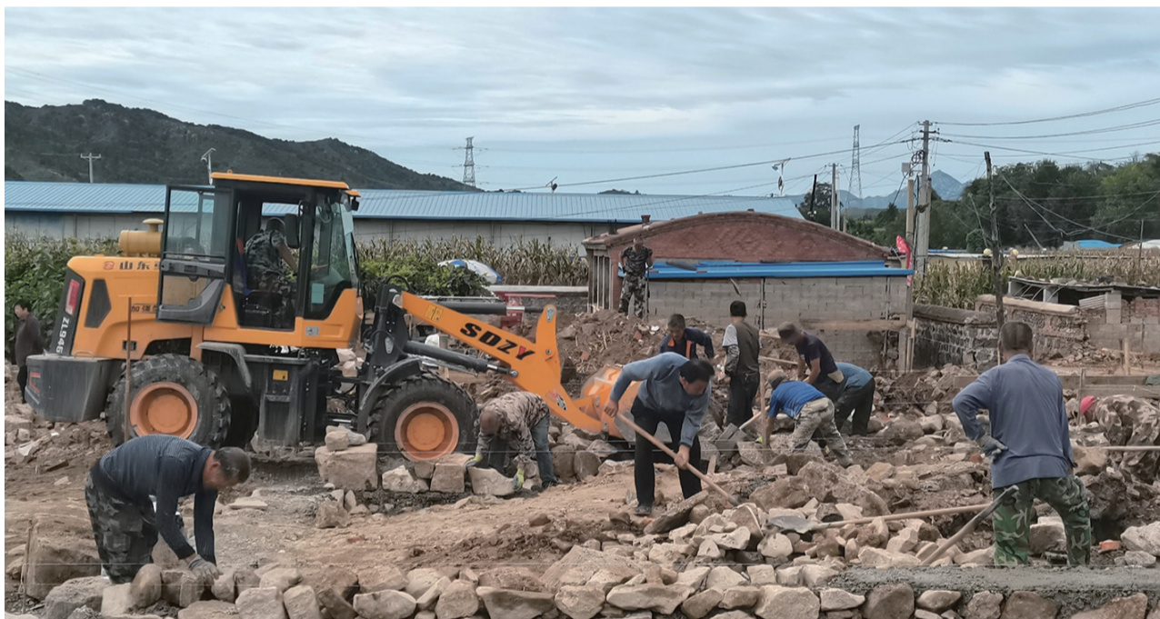
目前,葫芦岛市所有洪灾中受损房屋的重建工作已全部启动。
