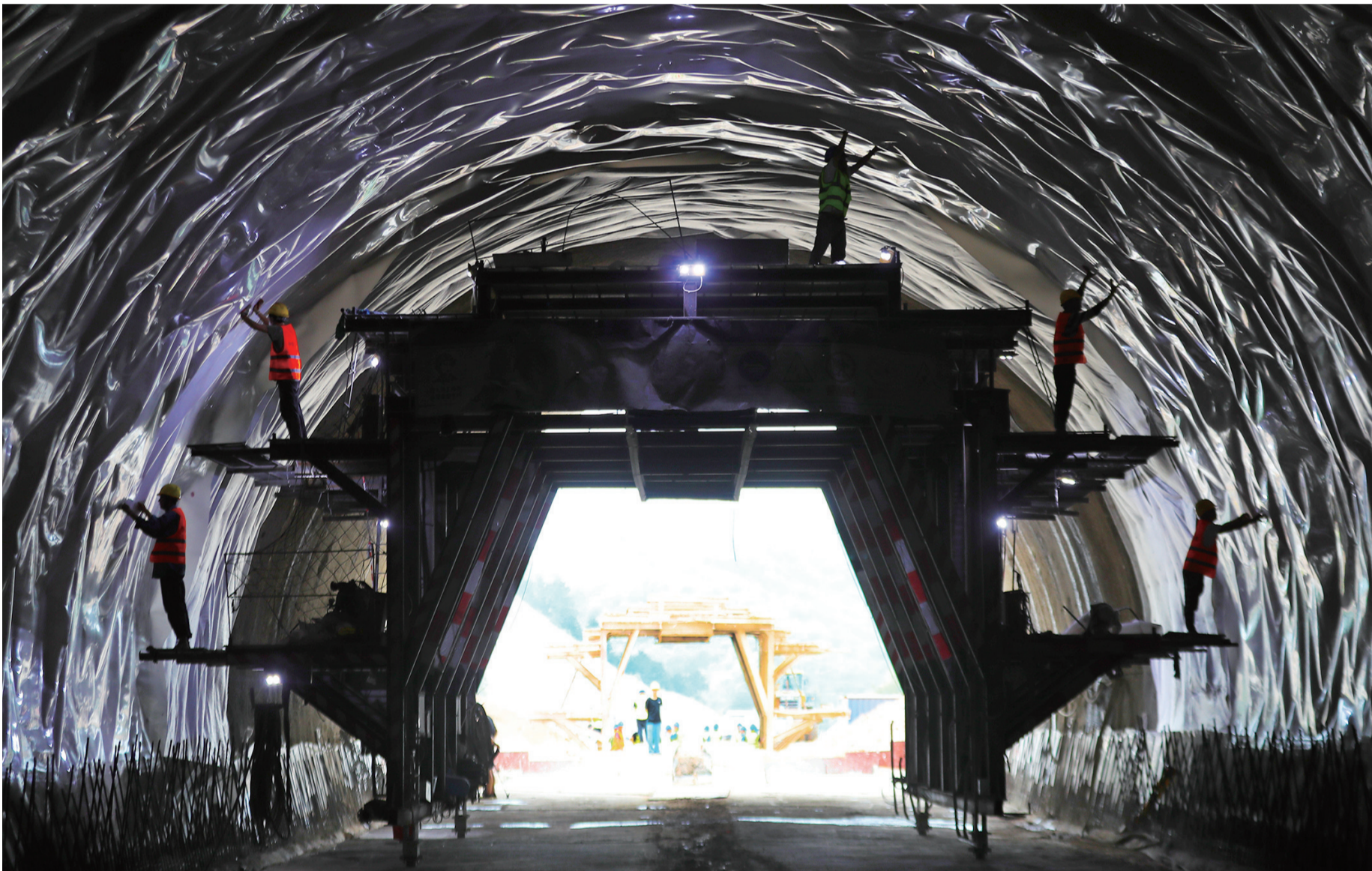
8月13日,中铁二十局建设者在隧道内进行防水板铺设。
