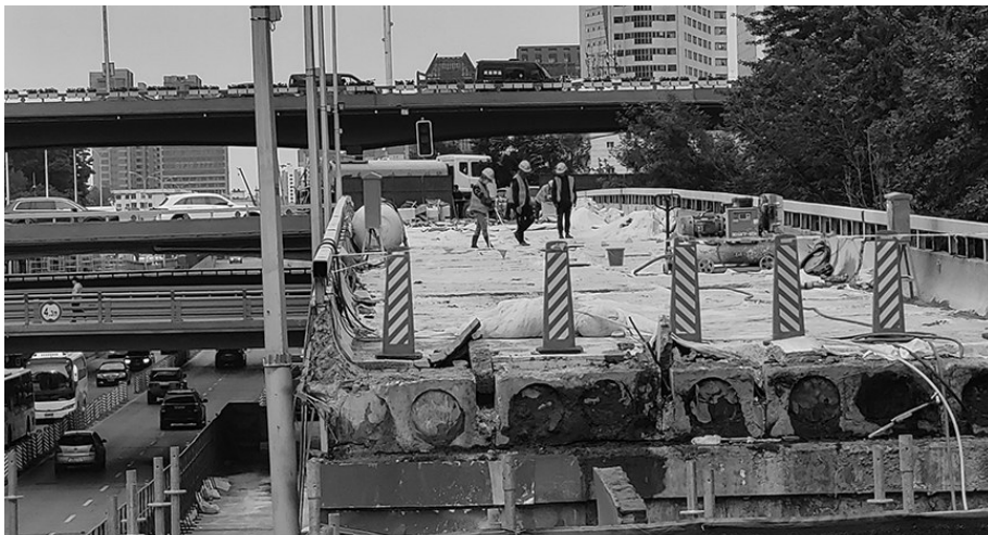
5月30日,沈阳市文化路立交桥正在进行桥板拆除工程。
