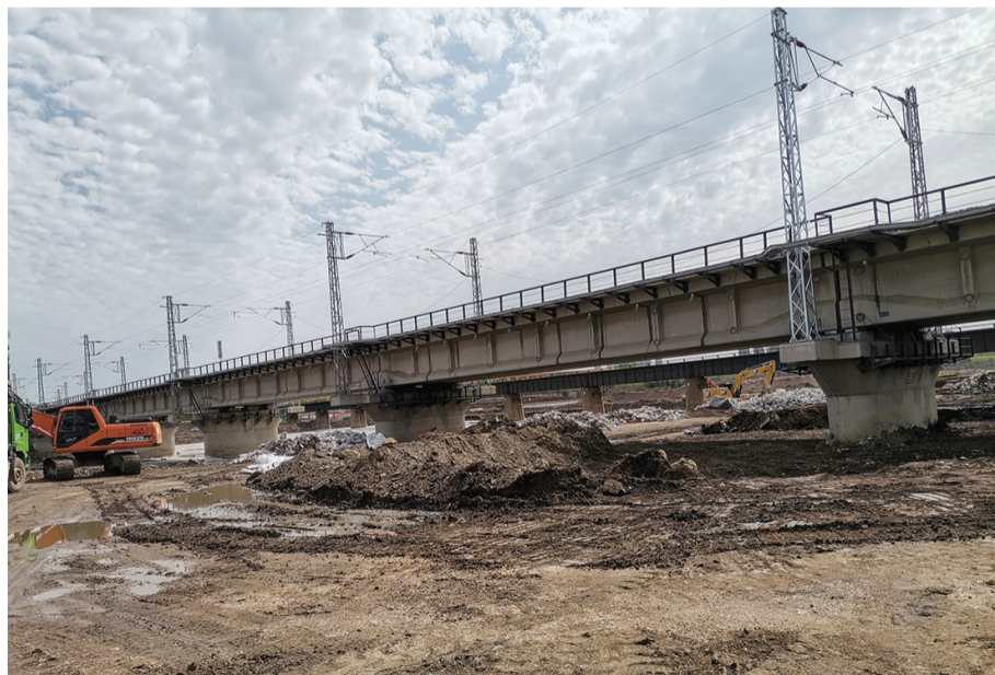
锦承铁路旧线桥将进行改造,成为一处新的铁路文化景观。
