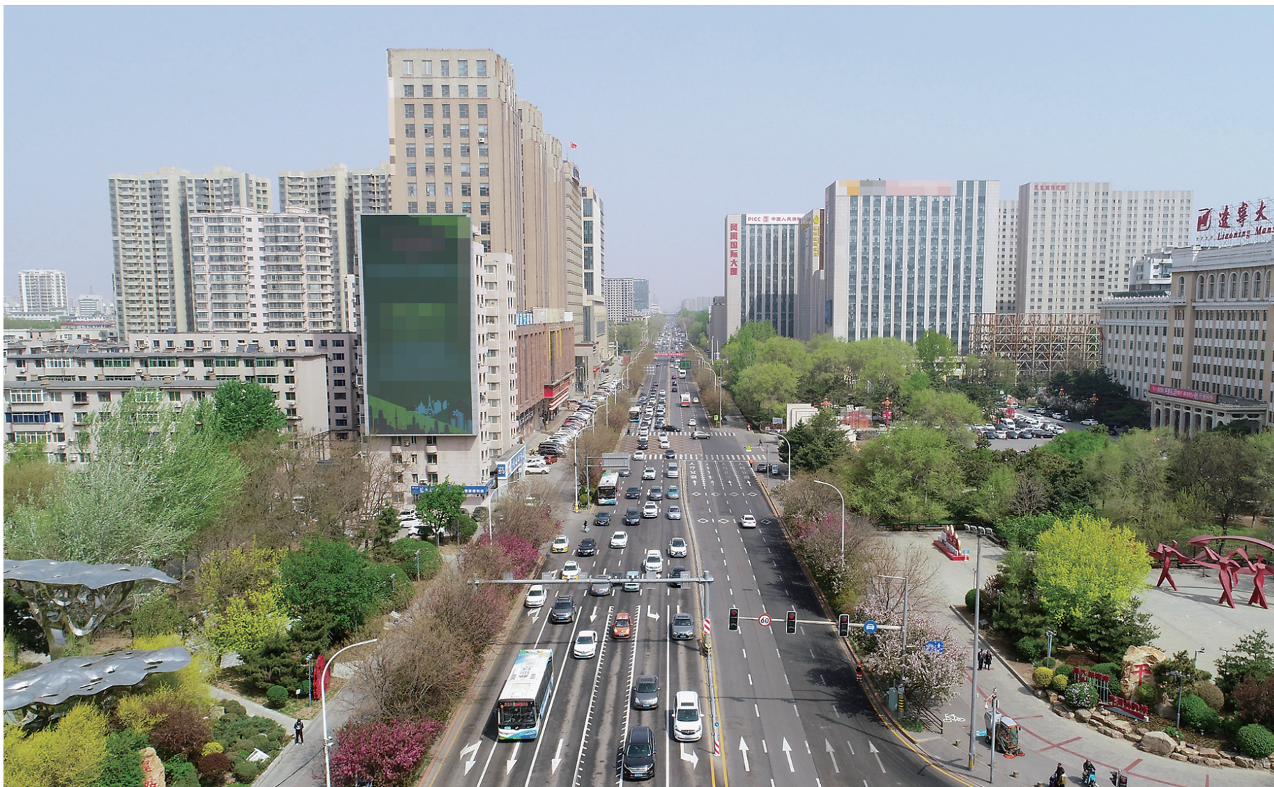
4月24日开始,沈阳市南京街、黄河大街启动全面更新维修。
