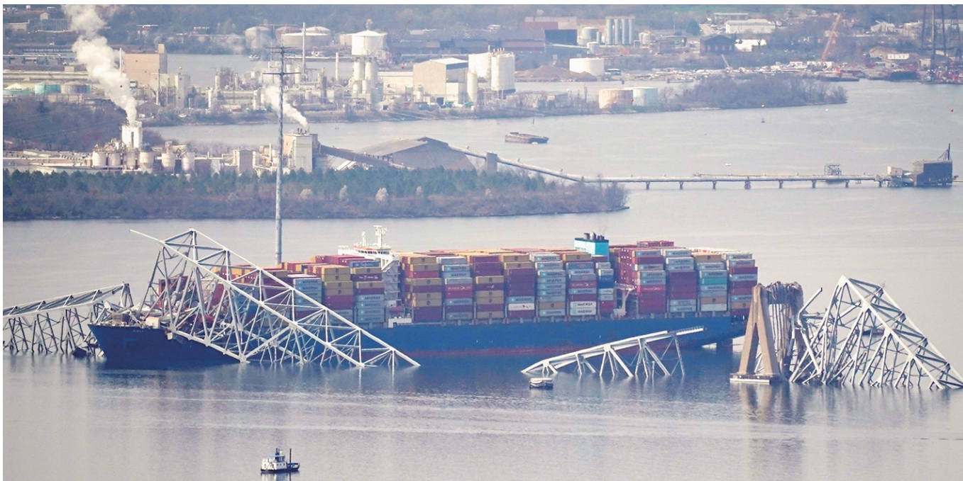
这是3月26日在美国巴尔的摩拍摄的撞击“弗朗西斯·斯科特·基”大桥的集装箱船。
