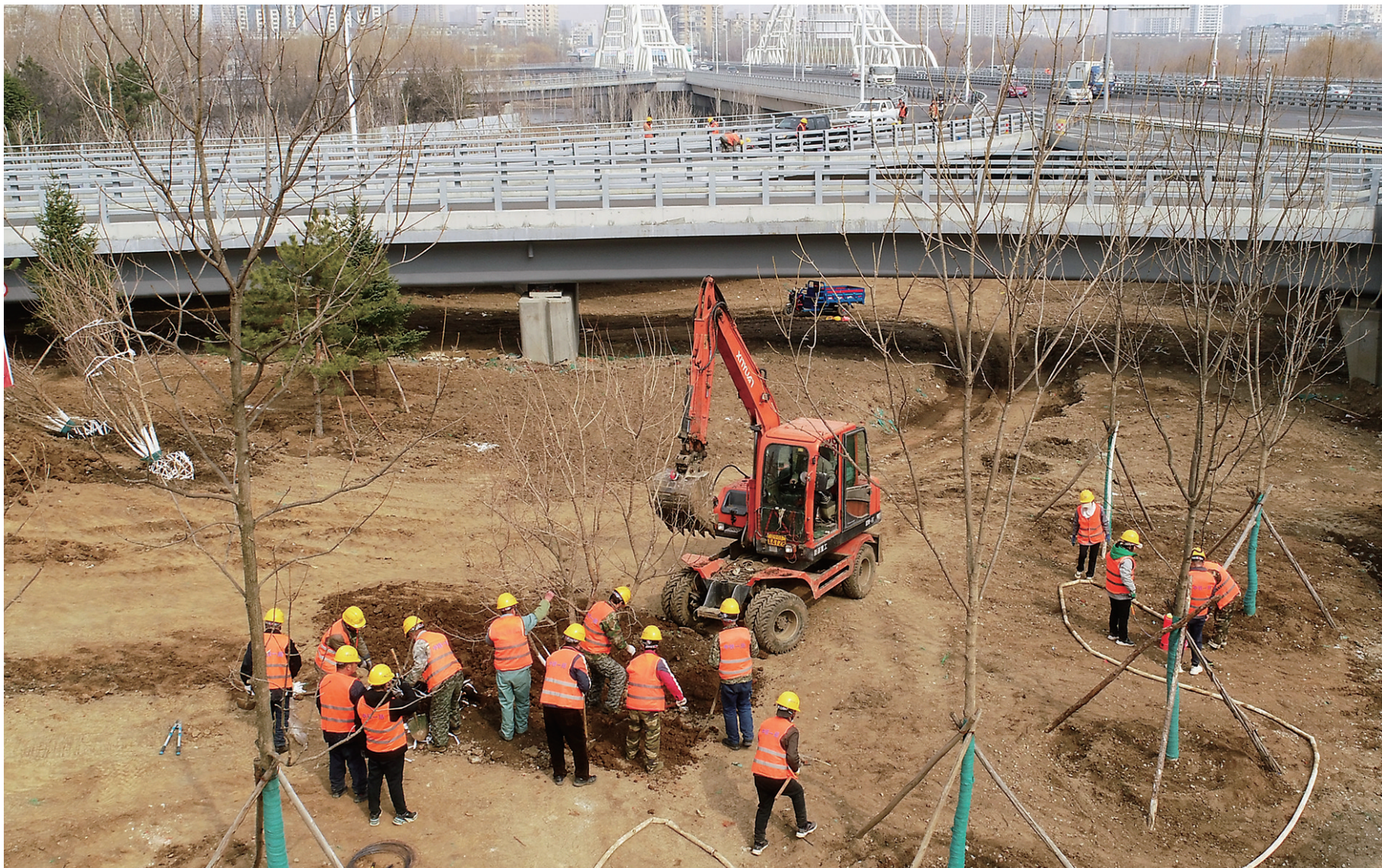
3月27日,沈阳市南京桥附属绿化工程正在建设中。
