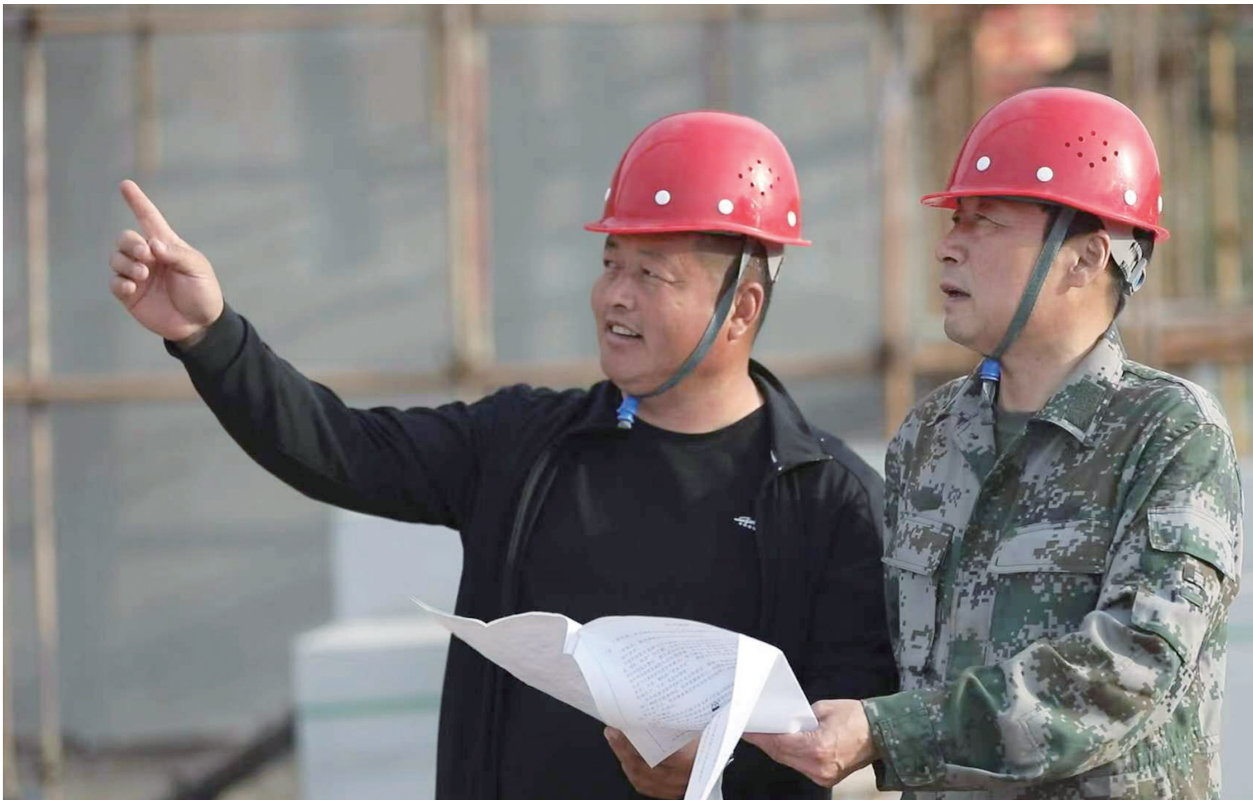
李炳旭(右)在村里工地现场。
