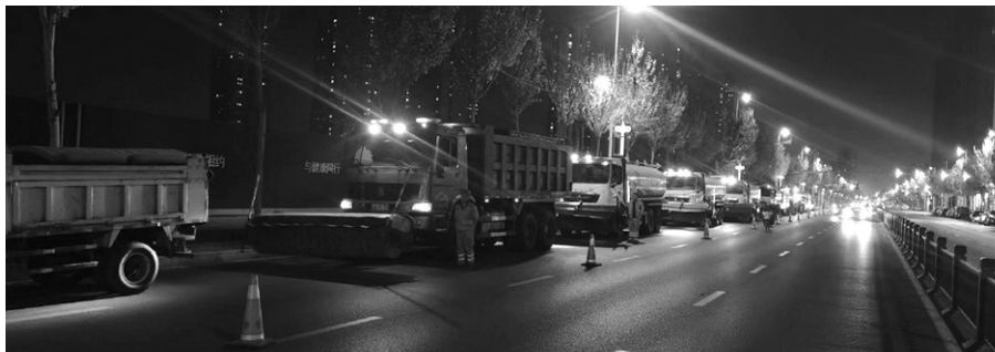
11月1日晚,沈阳市除雪办开展除雪现场演练。
