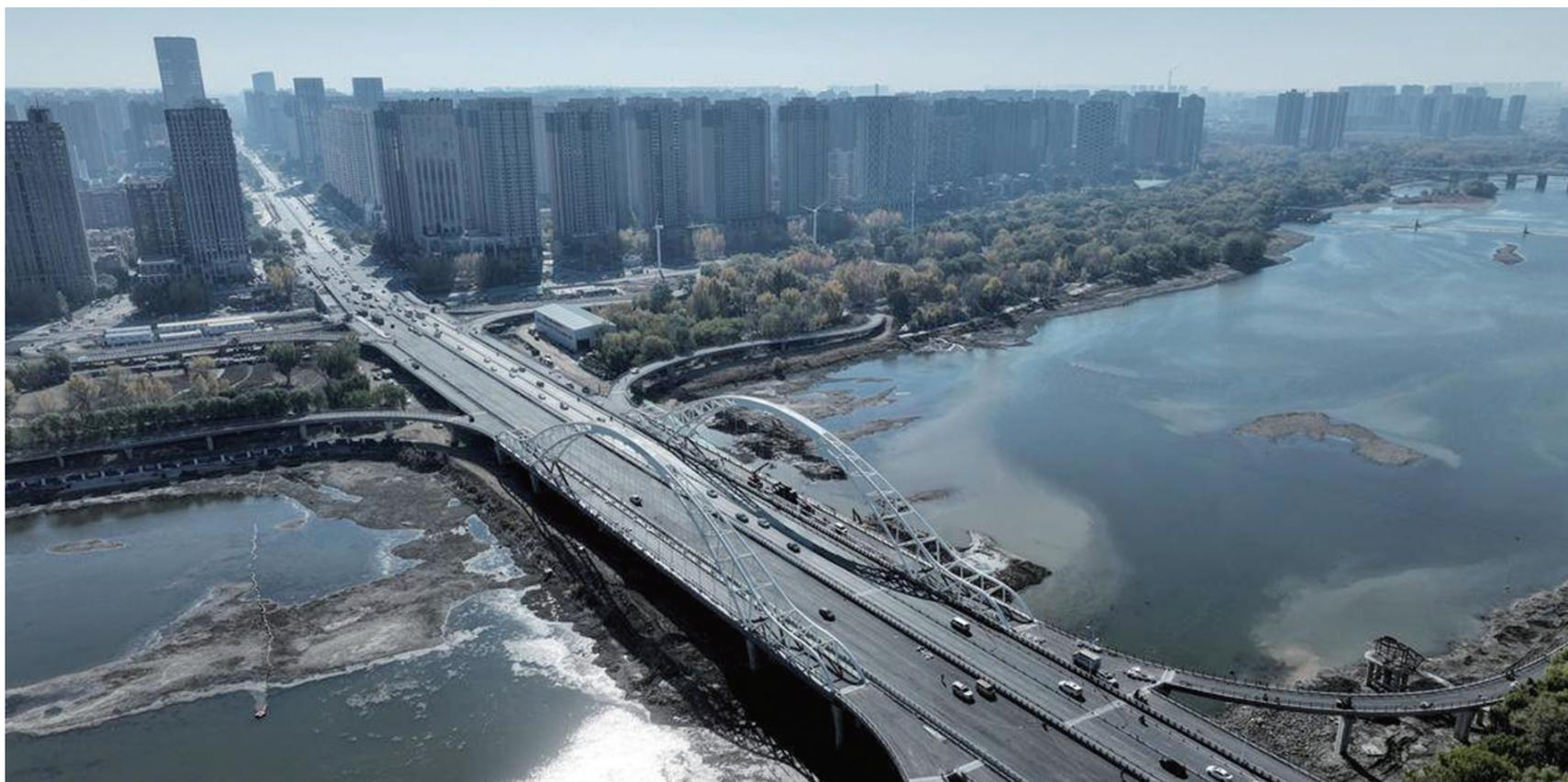
10月27日,工农桥改造工程中最大亮点之一的东西两侧“曲线钢箱梁桥”完工亮相。
