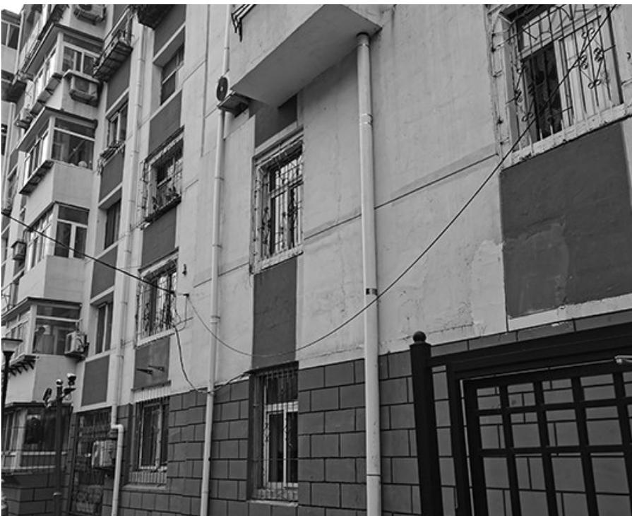
从3楼阳台直排的下水管,已连接到地下并前行66米,最后将污水排入6单元旁的污水井。
