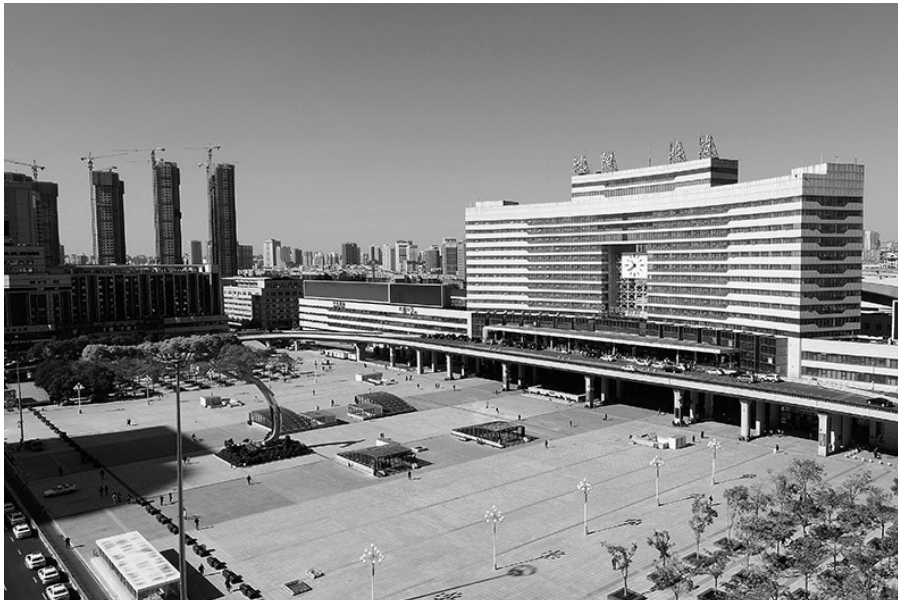
10月15日,沈阳北站南广场及北站路改造完成。
