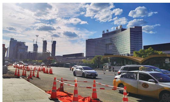
北站路更新改造工程过半 计划9月30日全面通车 02
