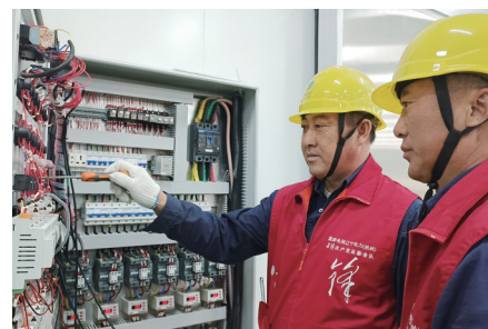
国网昌图县供电公司工作人员进行安装调试。受访者供图
