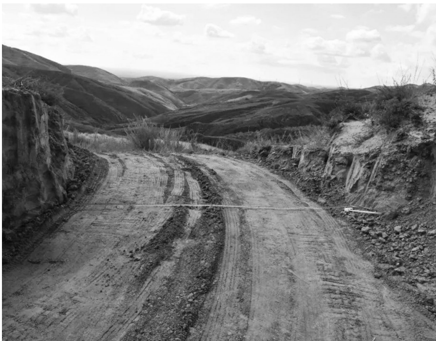
被挖掘机破坏的右玉县三十二长城段。
