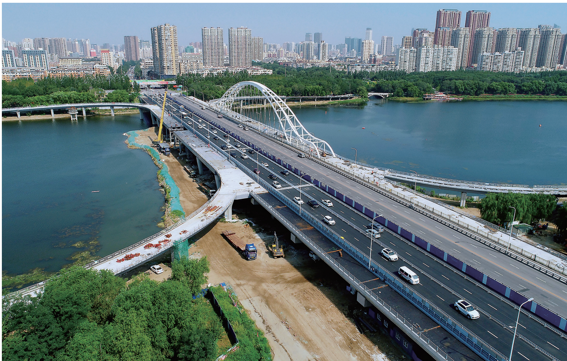
9月3日,沈阳市工农桥新建西幅车行道已通车。
