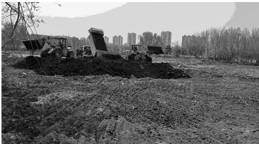
目前,塔北城市公园二期项目已全面进场施工。
