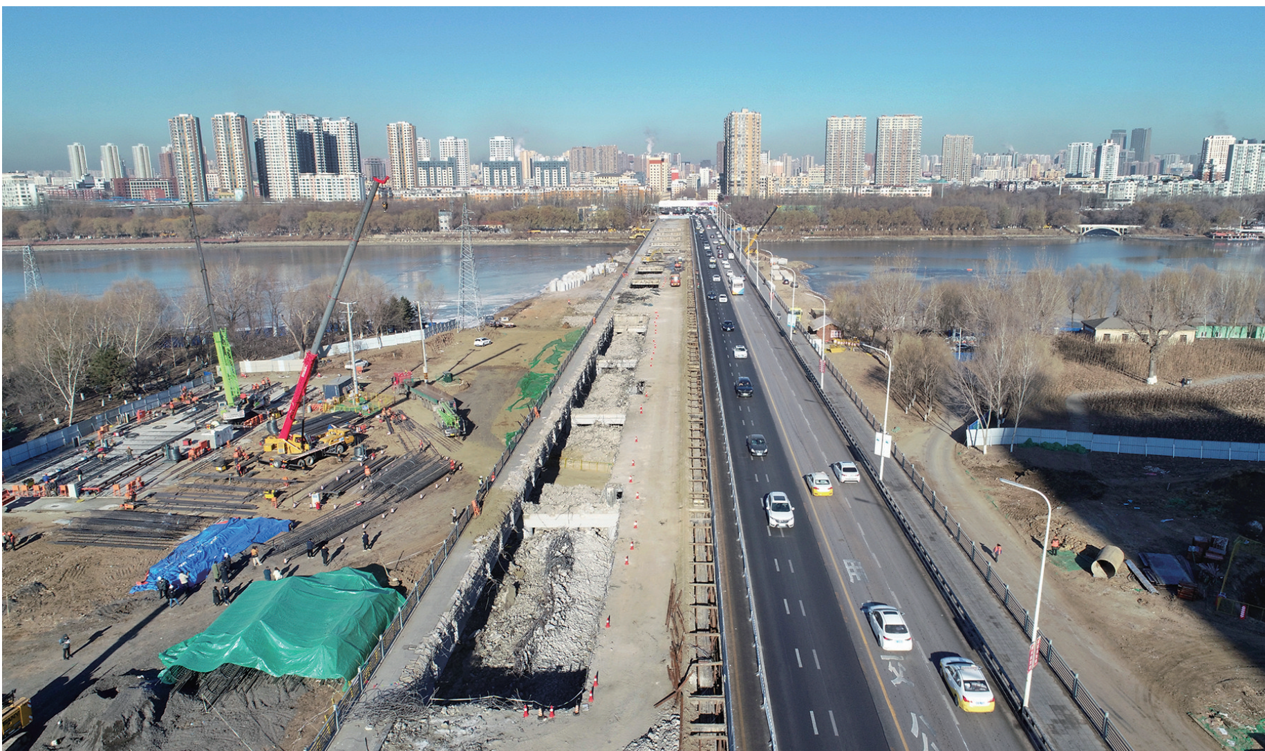
12月8日,沈阳市工农桥改造正在施工,西幅桥面部分已拆除。
