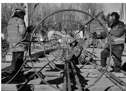
工人们正在施工。
