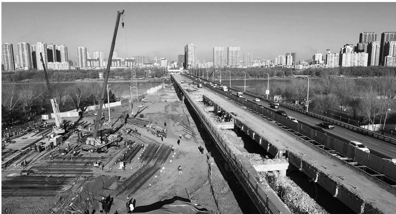
12月8日,沈阳市工农桥改造正在施工,西幅桥面部分已拆除。
