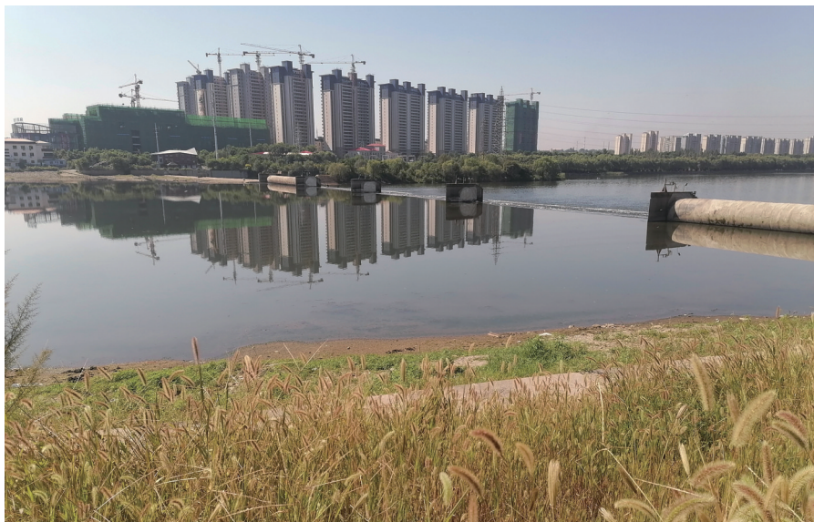
葛布橡胶坝5个坝袋有3个因损坏暂无法起坝蓄水,目前正在维修中。 辽沈晚报记者 李毅 摄
