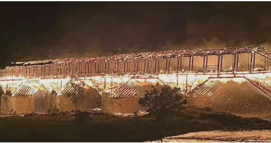
8月6日晚,福建宁德屏南万安桥突发大火,桥体已烧毁坍塌,无人员伤亡。
