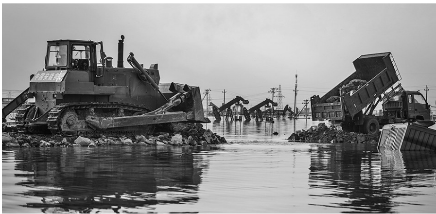
8月6日,抢险人员在溃口处进行封堵作业。
