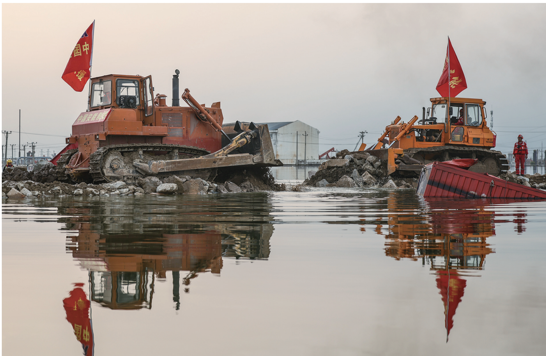
8月6日, 经现场抢险人员连续5天奋战, 辽宁绕阳河溃口封堵完成合龙。
