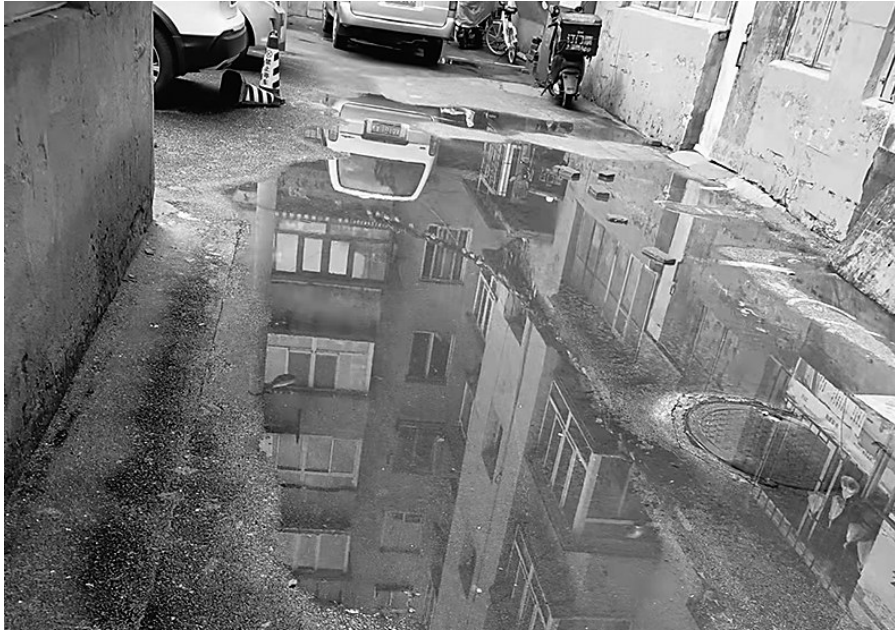
小区内的五六个下水井已经返水半个多月时间。
