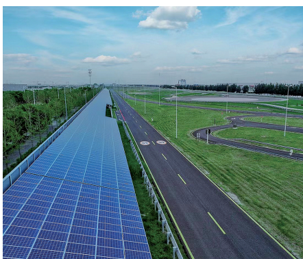
自2019年起宝马沈阳生产基地已实现100%可再生能源电力供电。
