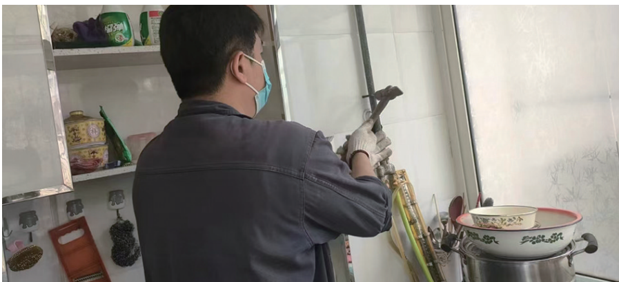
维修人员更换了新的燃气胶管。
