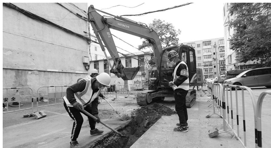
沈阳泉园一路15巷7号楼楼下,供水管网改造施工正在进行中。
