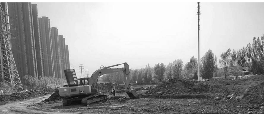
沈阳市于洪区滨江街社区公园正在有序建设中。
