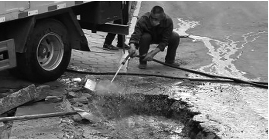
维修人员用吸污车、运输车等进行现场翻修。
