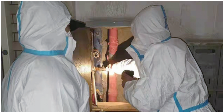
沈阳水务集团志愿者服务队化身“大白”在管控区抢修爆裂管线。 水务集团供图
