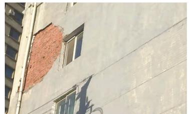
读者向“辽沈帮帮帮”爆料,沈阳市皇姑区汾河街15号楼,临近马路一侧有严重墙皮脱落。脱落墙皮位置位于楼体的5楼与6楼之间位置,面积比一个窗户还大,已经裸露出内部红砖。记者注意到,在墙皮脱落位置下方的人行道上,并没有设置任何防护措施,一旦有行人经过有一定危险。
