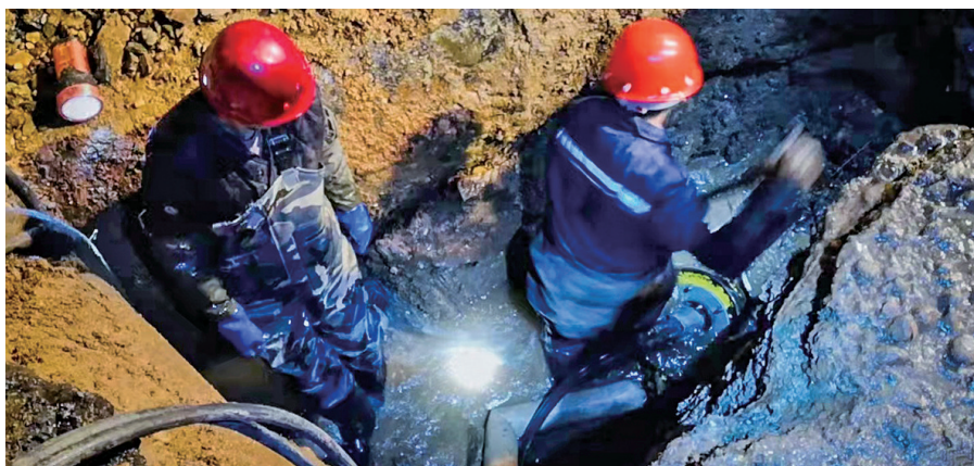
1月30日，抢修人员泡在冷水里进行抢修。
