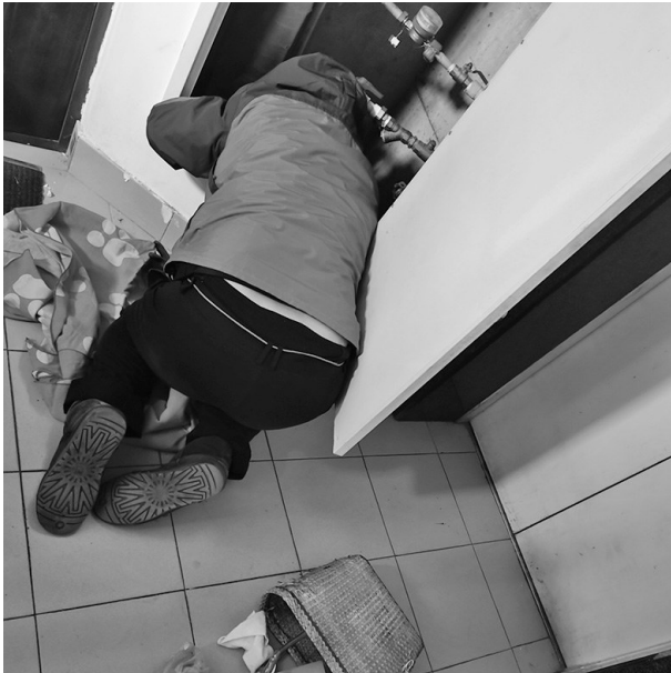
维修师傅庄国英正在处理供暖管道漏水问题。 受访者供图
