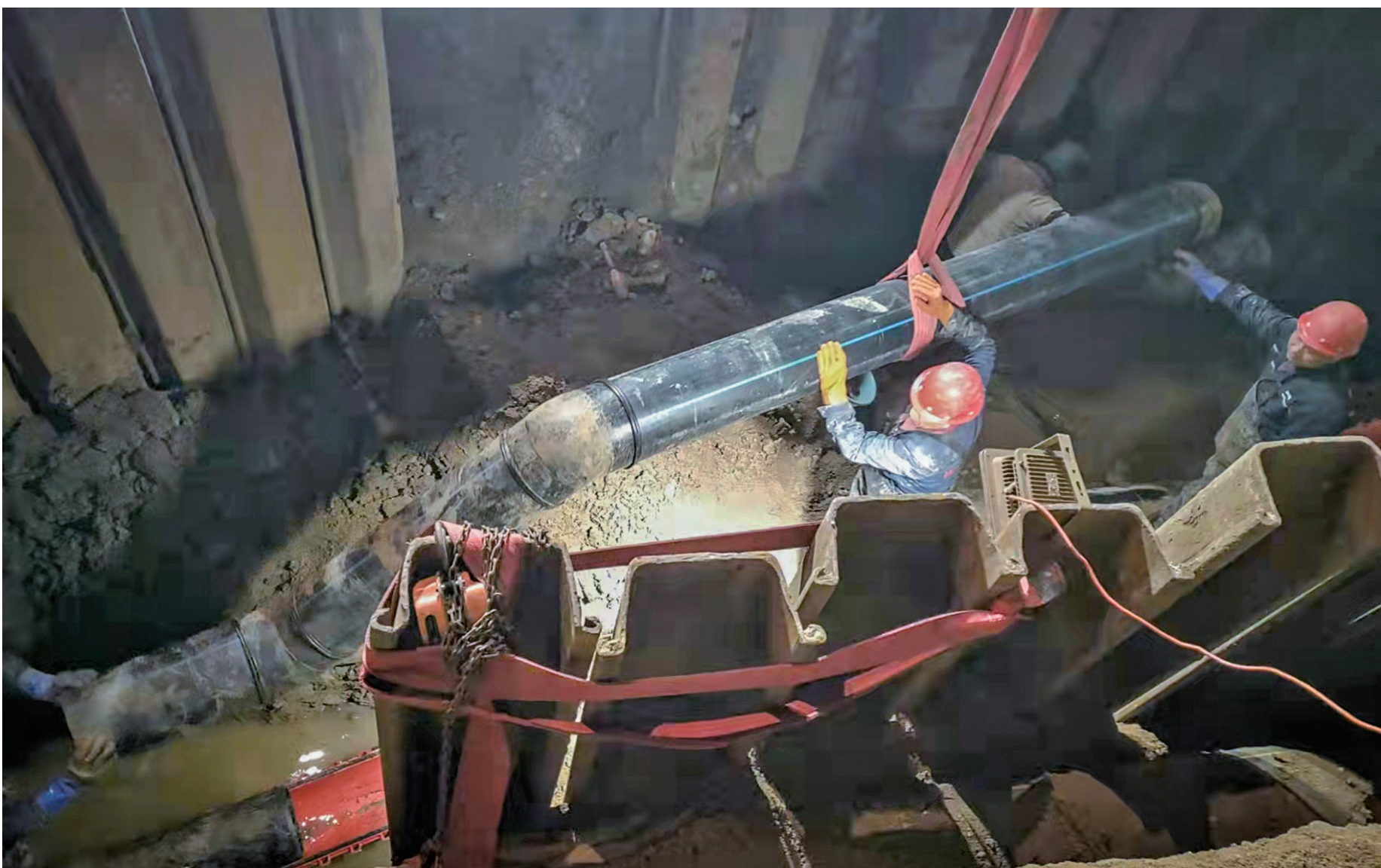
工作人员在棋盘山漏水现场进行抢修。
