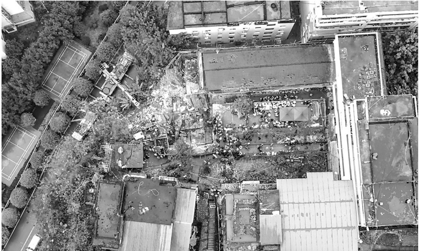
重庆武隆区凤山街道办事处食堂坍塌现场(无人机照片)。
