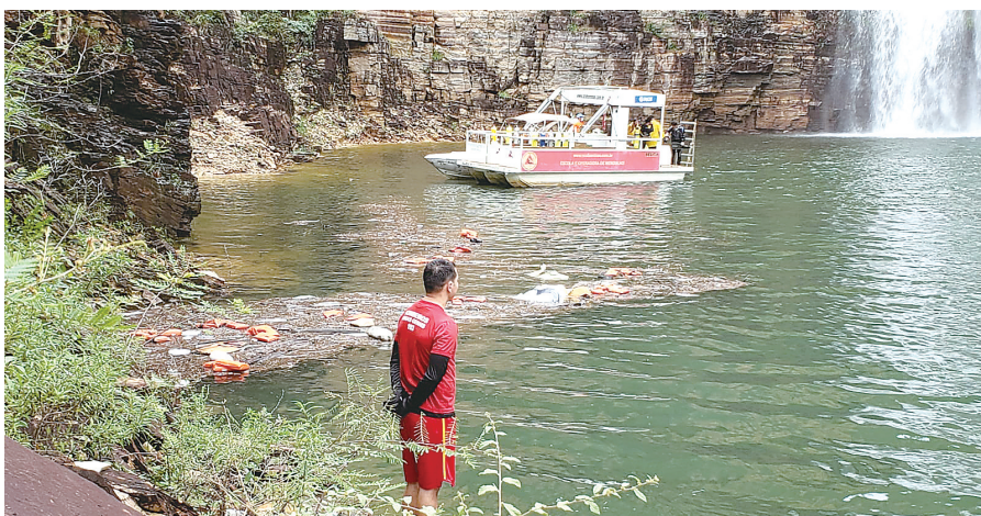
1月8日，救援人员在崖壁坍塌事故现场开展搜救工作。
