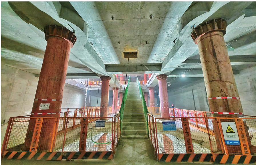
沈阳地铁四号线沈阳北站主体结构施工顺利完成。
