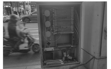
沈阳市和平区三好街和文萃路交会处南侧,一个设置在人行道上的电气箱门板缺失,是完全敞开状态,影响设备运行,同时有一定的安全隐患。
