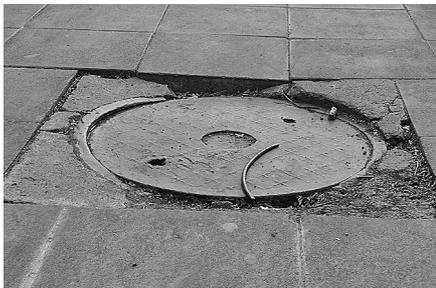
井盖边缘破损凹陷,影响行人和车辆通行。
