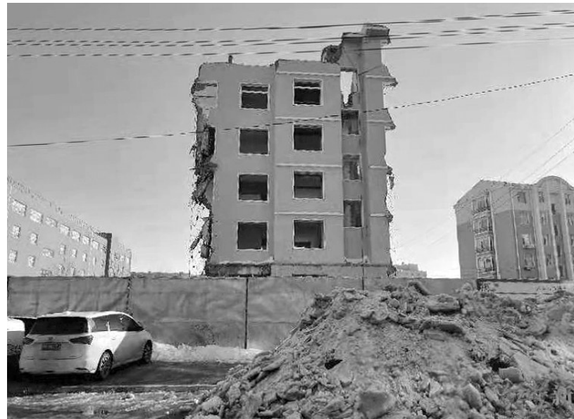
沈振勇所住居民楼被拆除。
